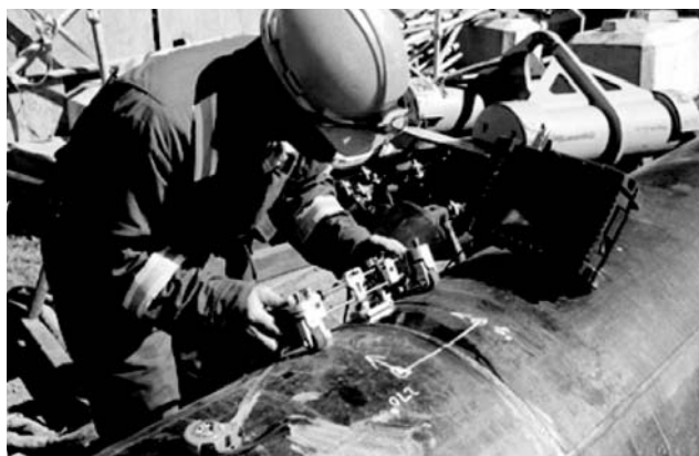
Нова інфраструктура зварювання трубопроводів
