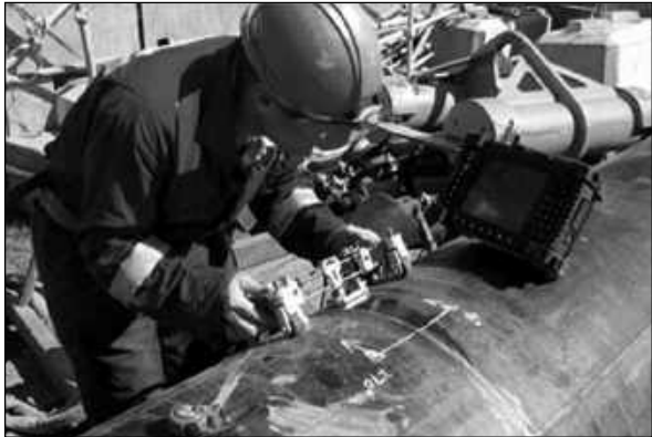
Нова інфраструктура зварювання трубопроводів
