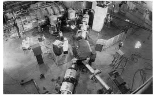
Ізохронний циклотрон У-240 Інституту ядерних досліджень АН УРСР
