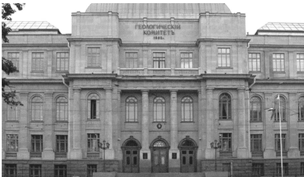
Здание Геологического комитета в Санкт-Петербурге.
