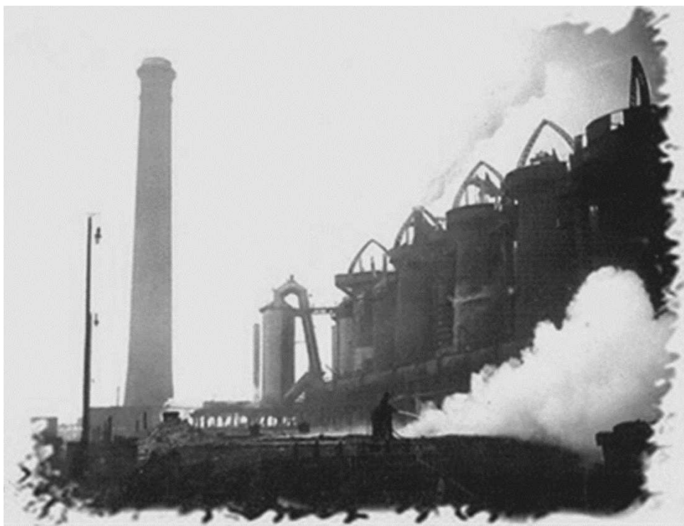
Процесс строительства «Криворожстали». Фото Э.К.Фукса.
